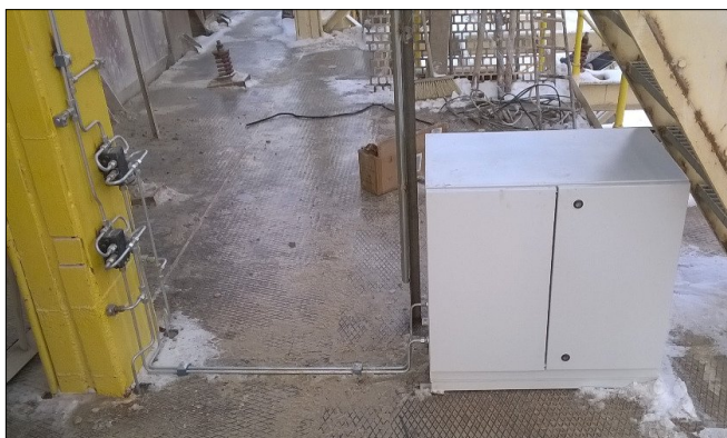
Rozváděčová skříň s čerpadlem a elmag. ventilem, vlevo primární progresivní rozdělovače SSVDL
