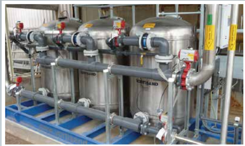
Filtrační systém pro výkon 100m³/h
